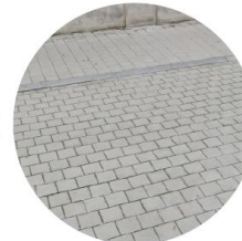
Vélos : Béton coulé scié
