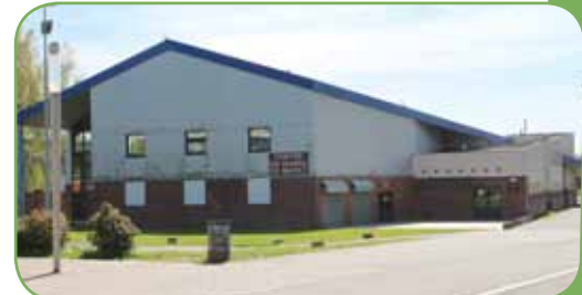
La Salle Schumann avant les travaux
